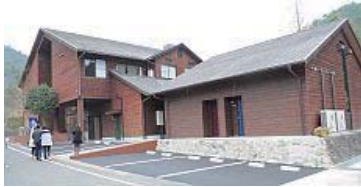
綺麗になったロッジは合わせて10室 5人・1室、4人・3室、6人・6室
